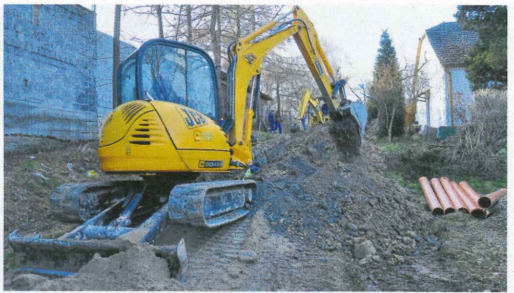
Roboty liniowe – budowa kanalizacji sanitarnej
