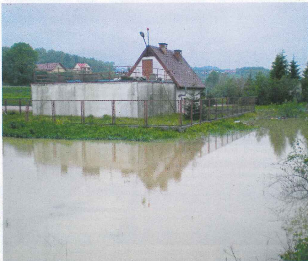
Oczyszczalnia ścieków w Bogoniowicach w czasie powodzi
