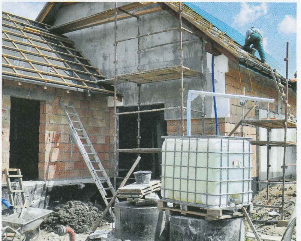
Przebudowa oczyszczalni ścieków w Bogoniowicach
