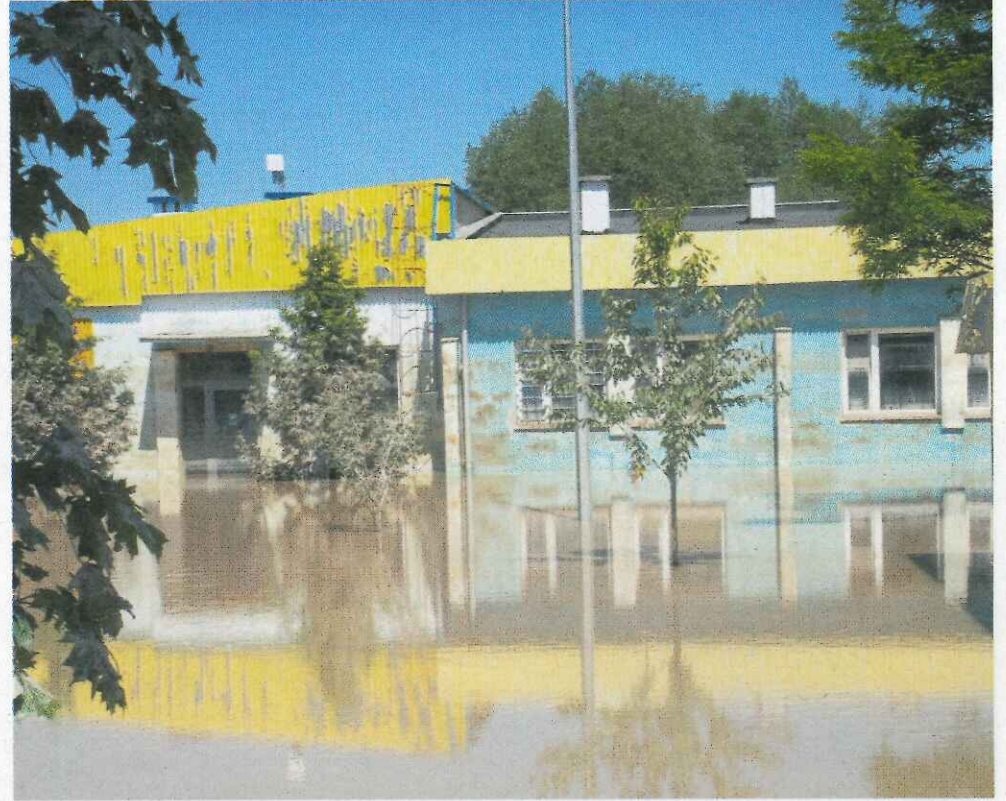
Budynki socjalno-techniczne oczyszczalni ścieków w Tuchowie tonie w wodzie
