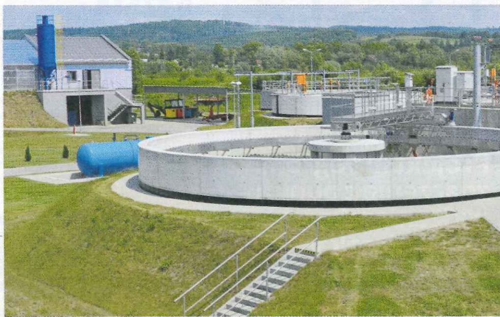
Oczyszczalnia ścieków w Tuchowie
