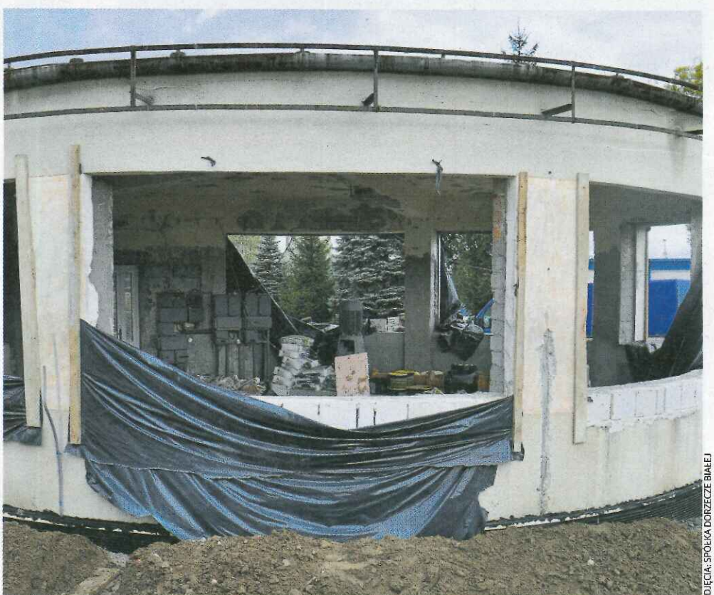
Remont pompowni wody surowej – stacja uzdatniania wody w Lubaszowej
