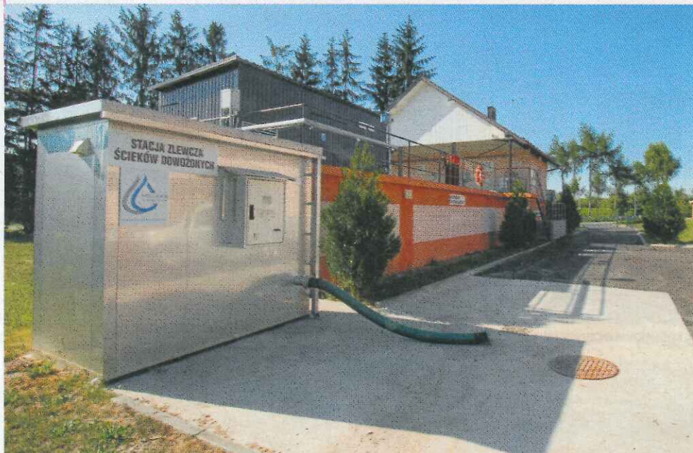
Oczyszczalnia ścieków w Ciężkowicach – stacja zlewcza, reaktor biologiczny i budynek socjalny
