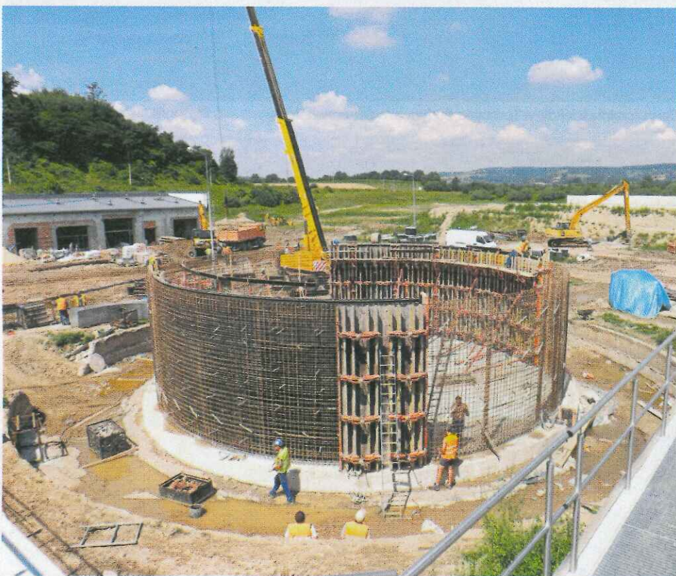
Budowa osadnika wtórnego oczyszczalni ścieków w Tuchowie
