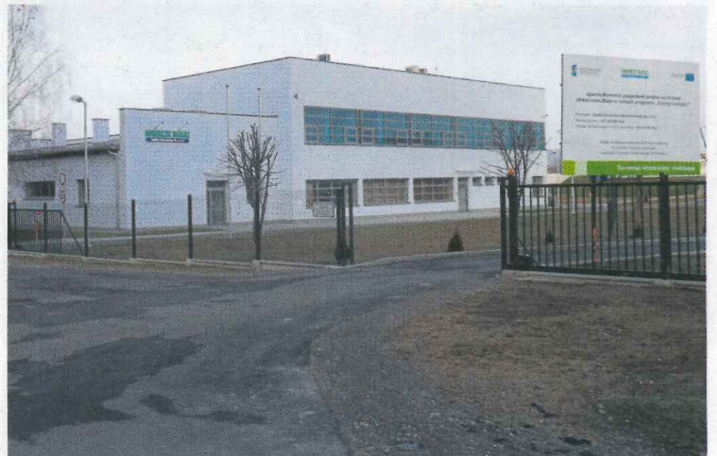
Oczyszczalnia ścieków w Tuchowie, budynek socjalno-techniczny
