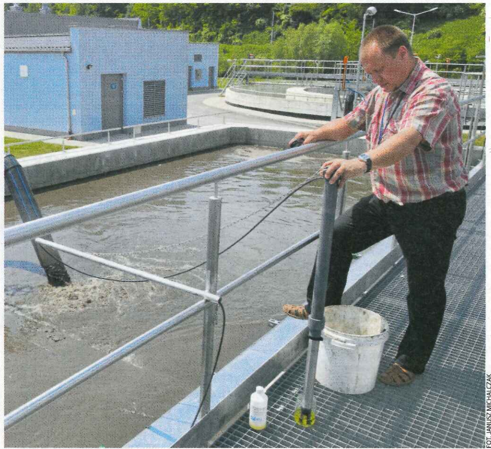
Reaktor biologiczny – oczyszczalnia ścieków w Tuchowie
