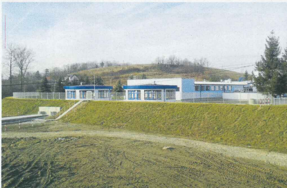
Widok na stację uzdatniania wody w Lubaszowej
