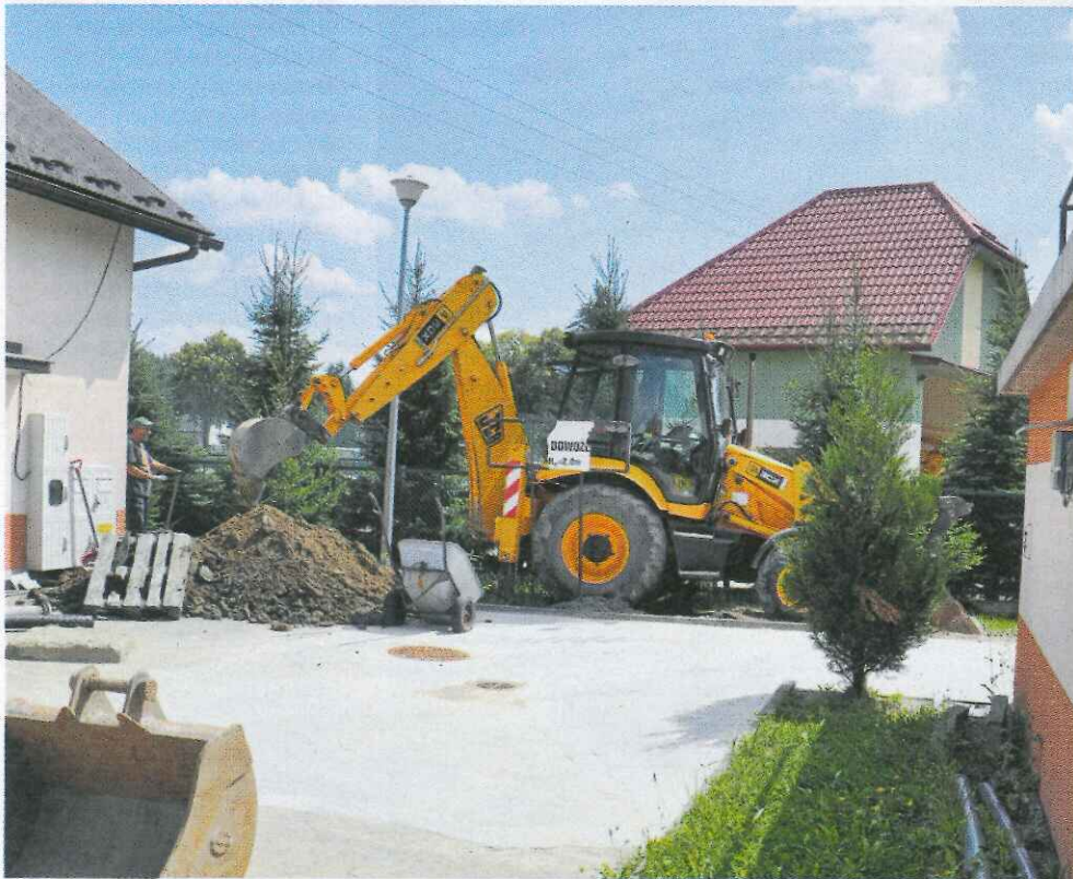
Roboty budowlane na terenie oczyszczalni ścieków w Ciężkowicach
