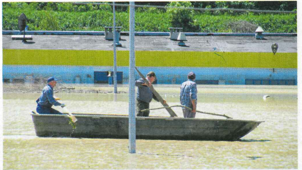
Powódź w Tuchowie, woda zalała budynki oczyszczalni po dachy
