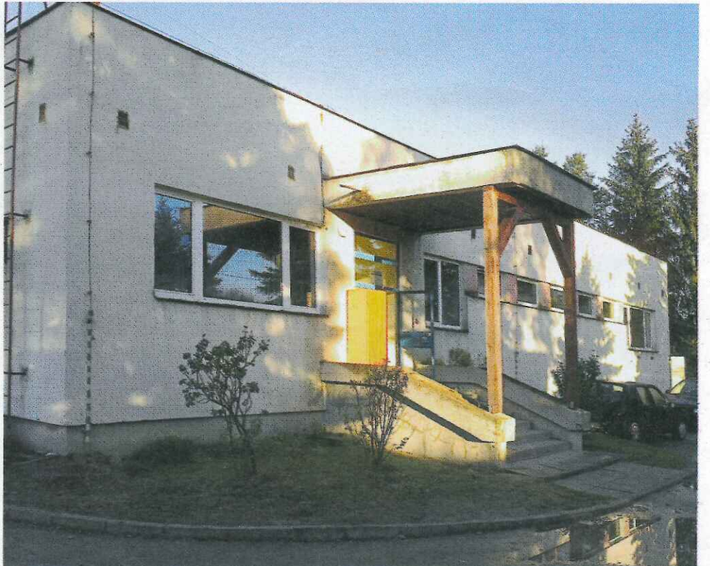
Budynek socjalno-techniczny stacji uzdatniania wody w Lubaszowej
