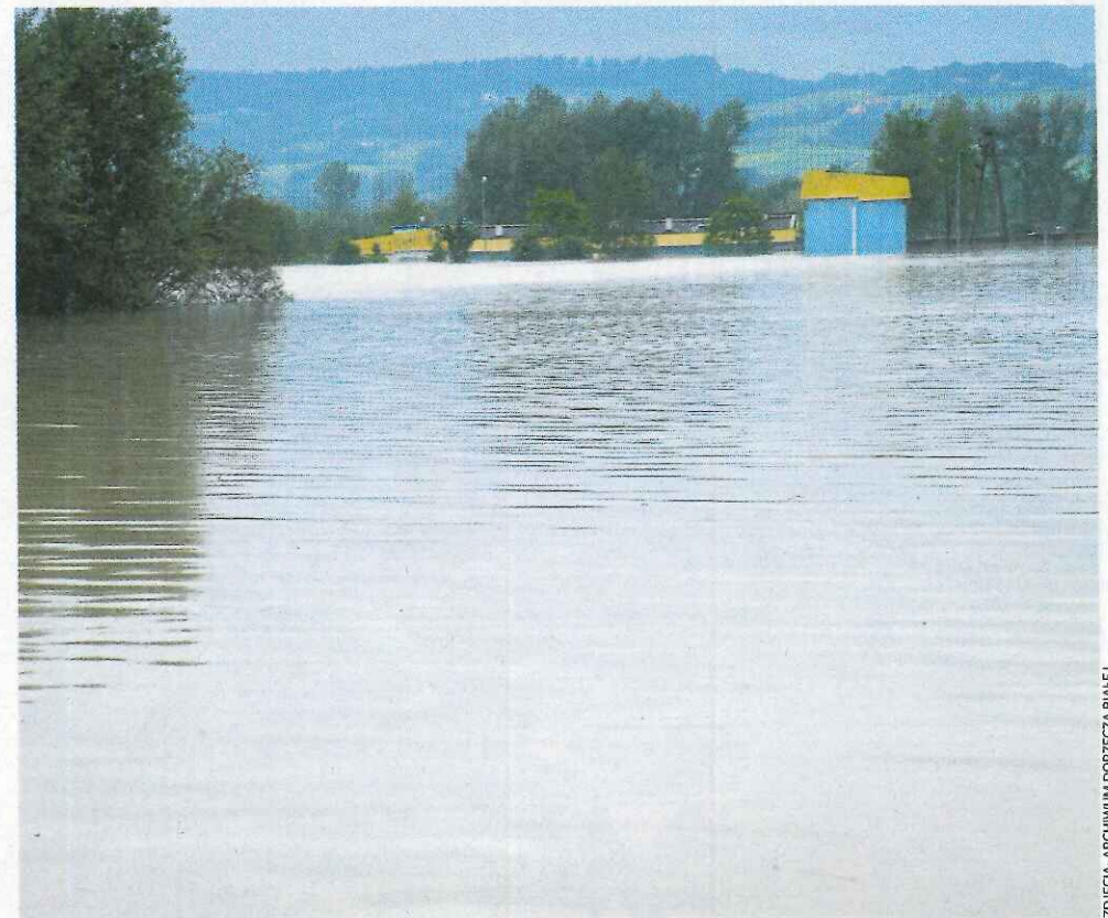
Oczyszczalnia ścieków w Tuchowie pod wodą
