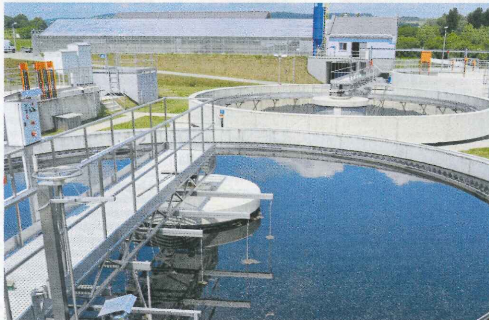
Widok na osadnik wtórny i suszarnię słoneczną osadu, oczyszczalnia ścieków w Tuchowie
