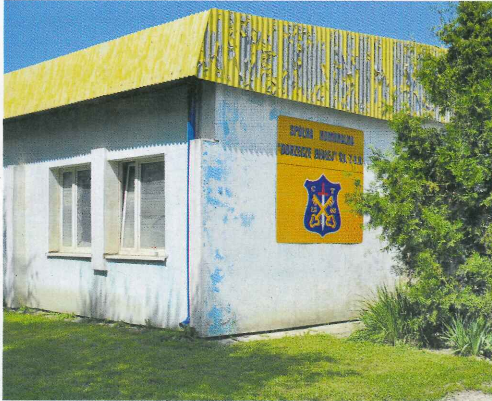
Budynek socjalno-techniczny oczyszczalni ścieków w Tuchowie
