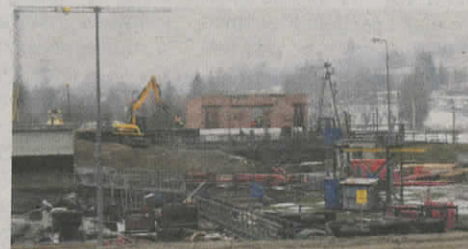
Prace budowlano-montażowe na OŚ w Tuchowie.
